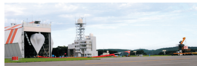
大気球指令管制棟(中央)とJAXA格納庫(左)。JAXA格納庫でヘリウムガスを注入した大気球をスライダ放球装置で引き出している
