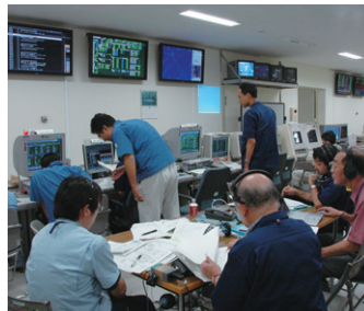
34mアンテナ室
