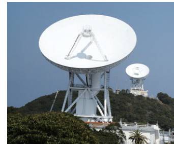
34mアンテナ(左)・20mアンテナ(右)
